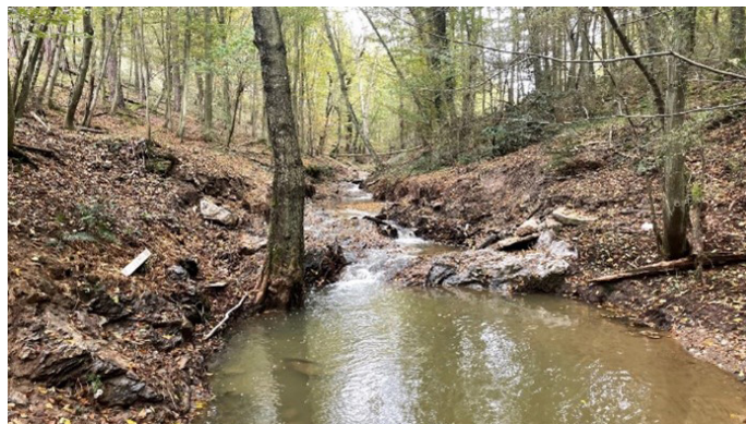
Après travaux sur le Mézerin 2024
