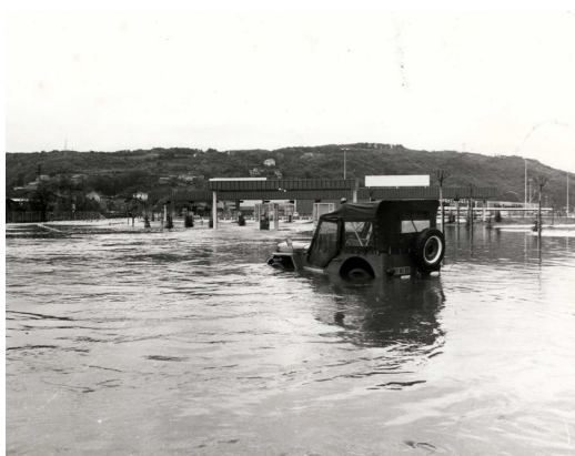
Crue du Gier mai 1977
